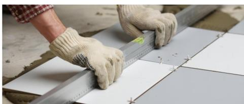
Dans le travail de carreleur, il prépare les supports horizontaux en vue de dresser la chape de finition et de réaliser la pose collée des carreaux. Il peut également réaliser une pose de carreaux sur chape fraîche. Il prépare et réalise les supports verticaux en vue de poser des carreaux. Il trace les marches, et rectifie le support de celles-ci et des contremarches afin de carreler un escalier.
